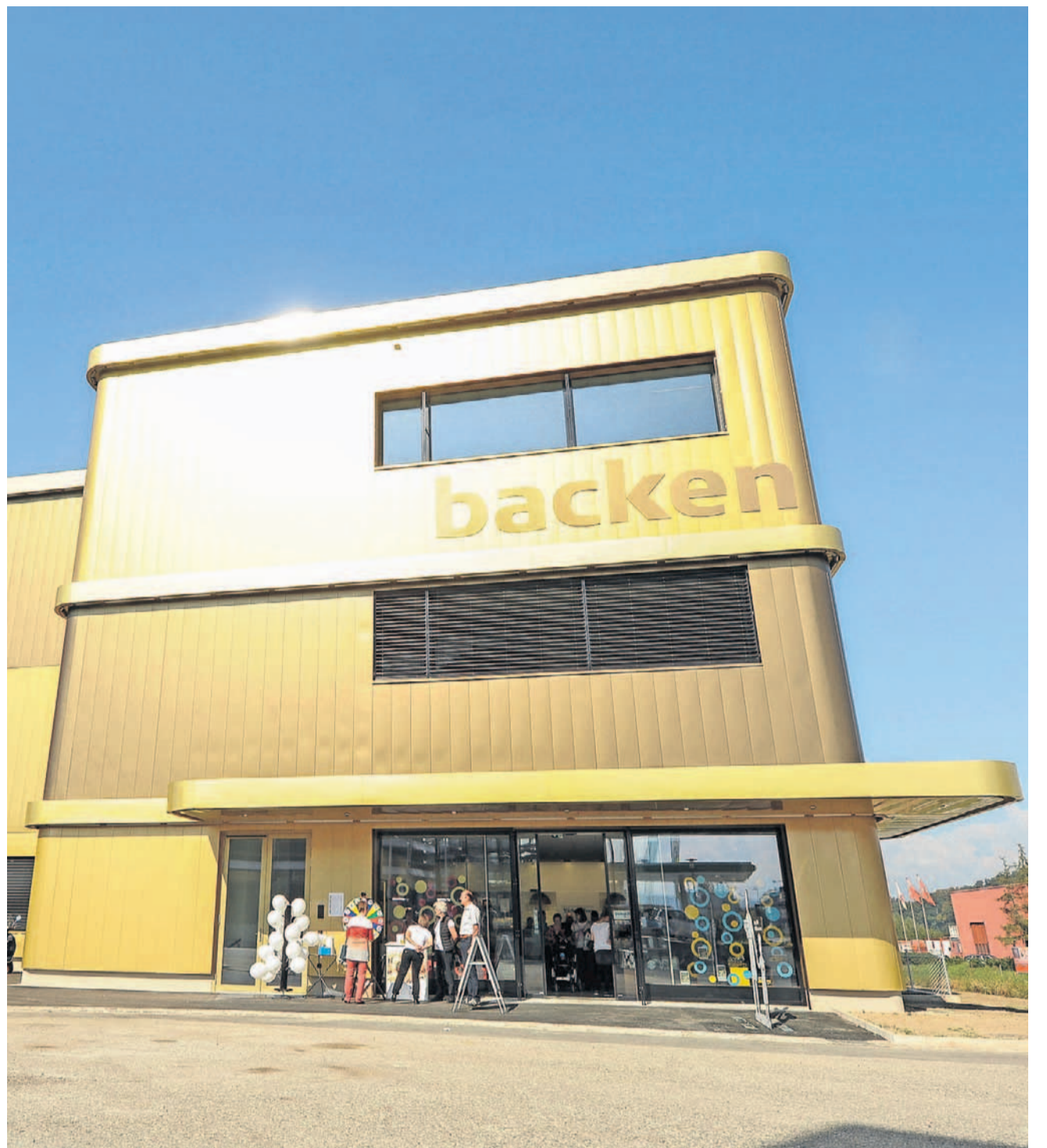
Das Gebäude sieht aus wie eine Läckerli-Blechdose und glänzt vor dem blauen Himmel.
